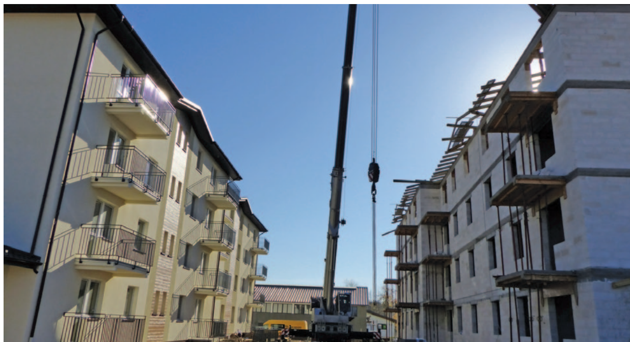
Pierwszy budynek będzie zamieszkały w grudniu
